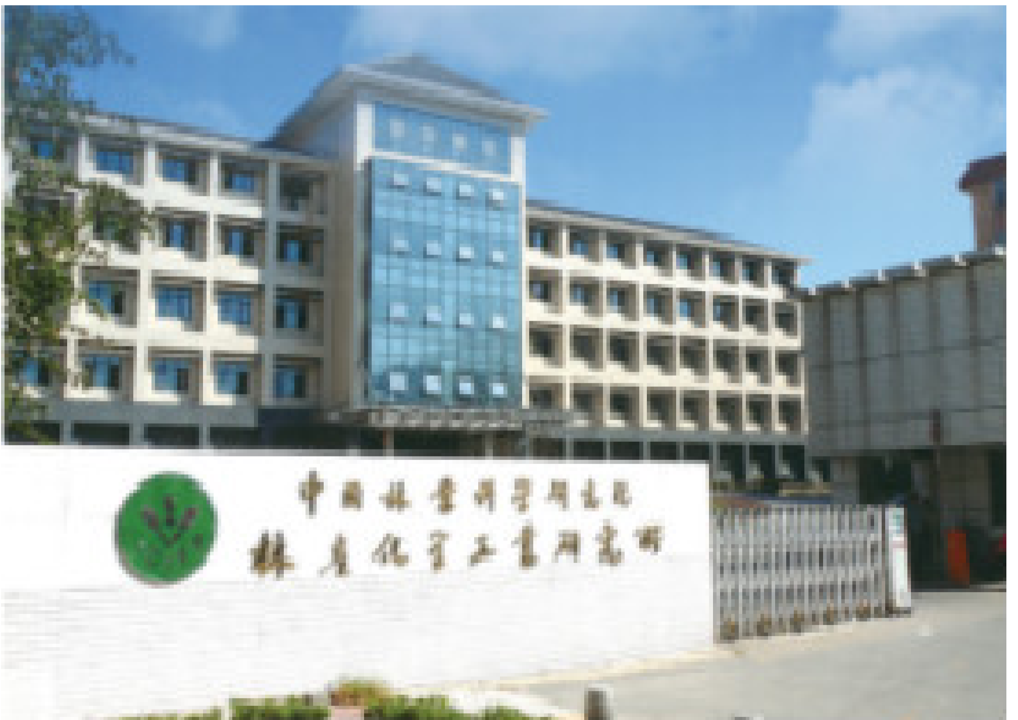
2010年改建后的科研大楼
