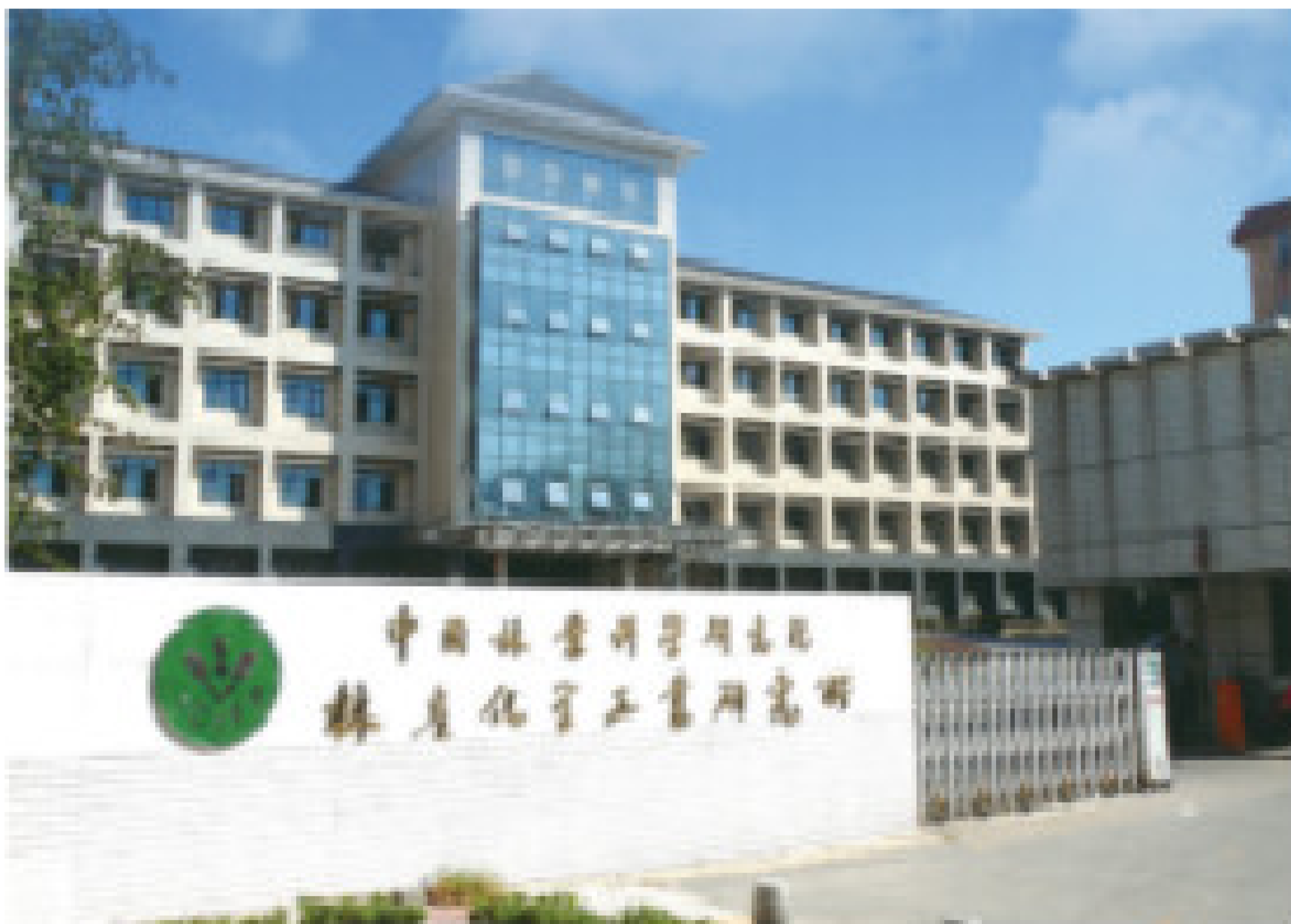
2010年改建后的科研大楼
