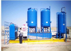
“车95井催化曝气脱硫工艺技术研究与应”项目通过验收
