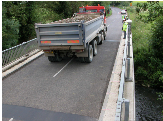
桥梁结构状态光纤智能监测系统
