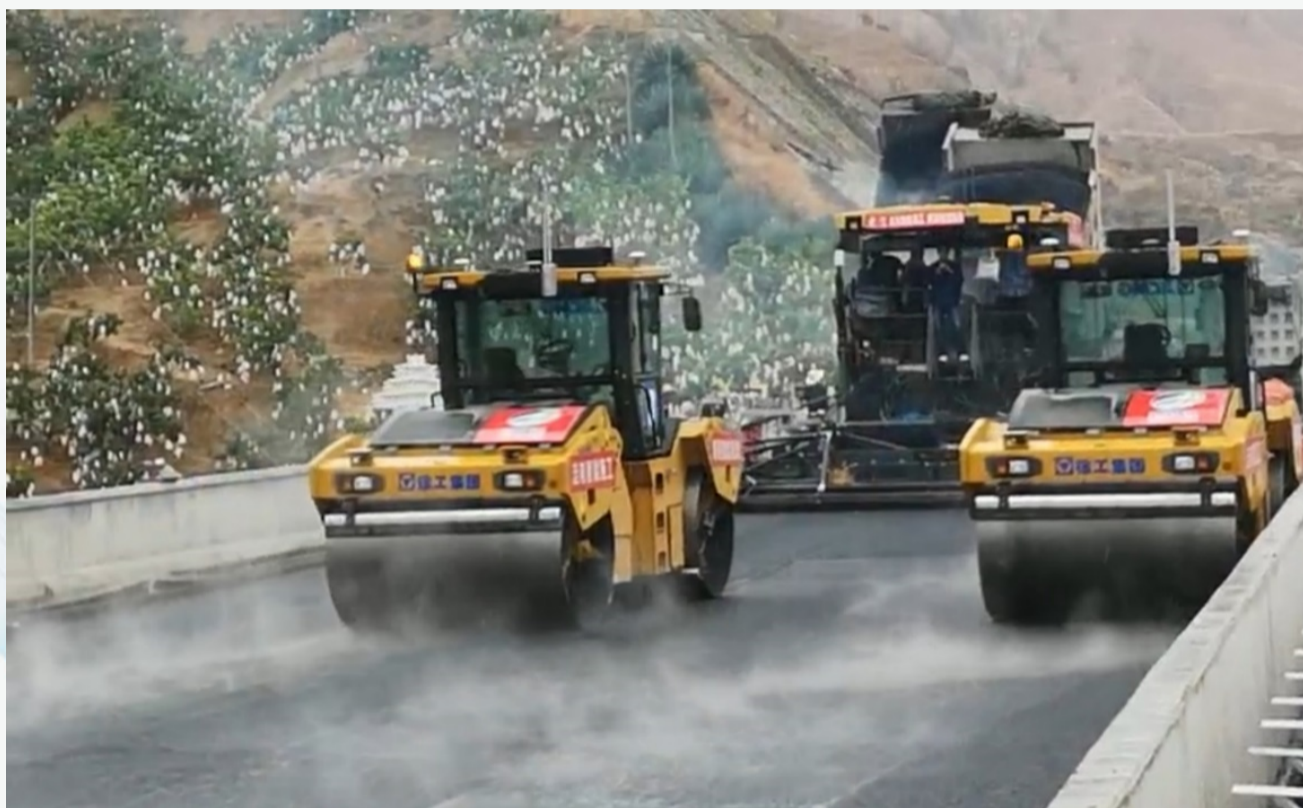
攀大高速全球首次应用无人机群施工
