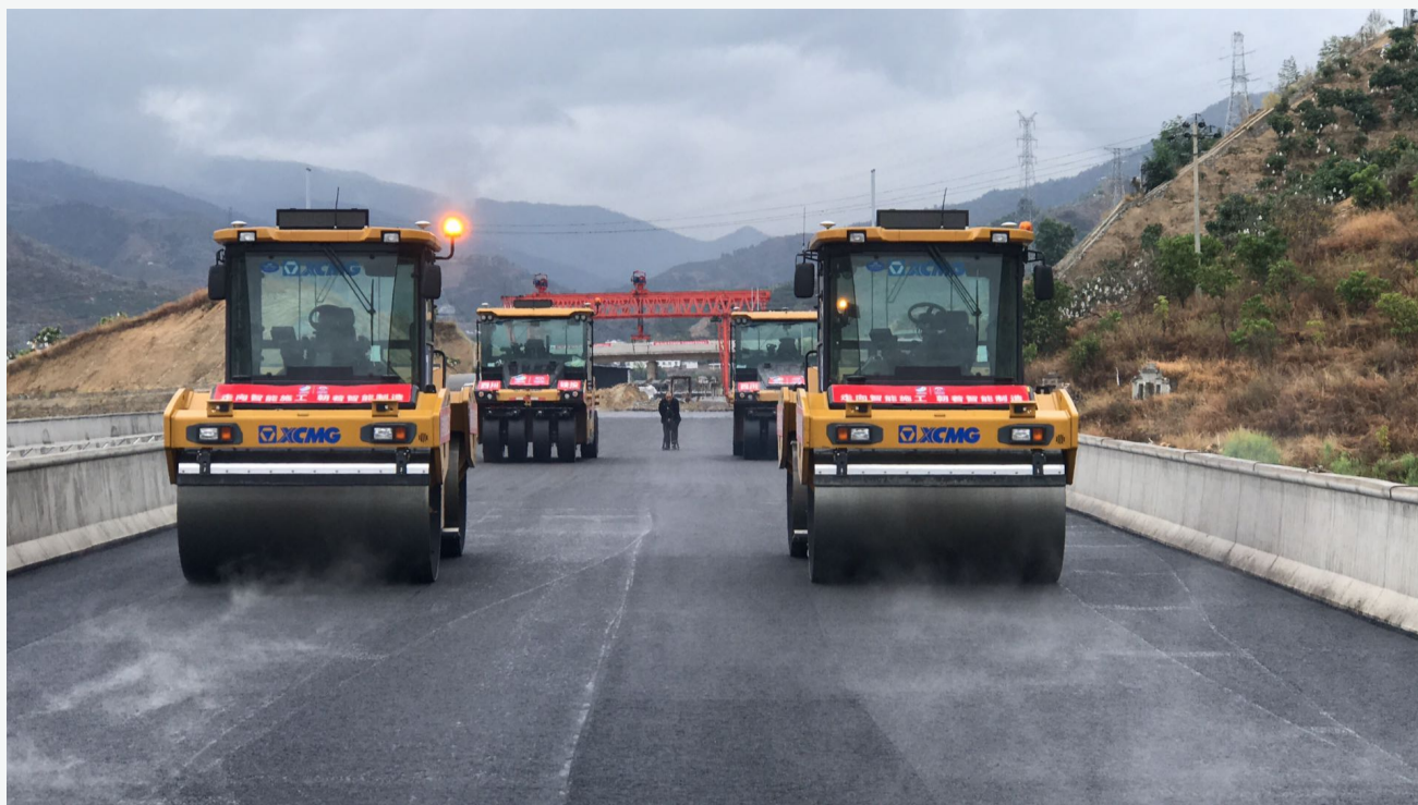
无人机群施工中
