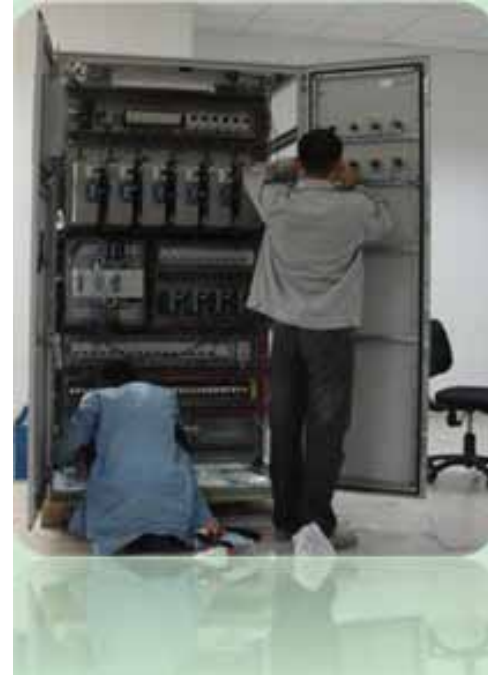
电装完成的副面调整机构电气控制系统
