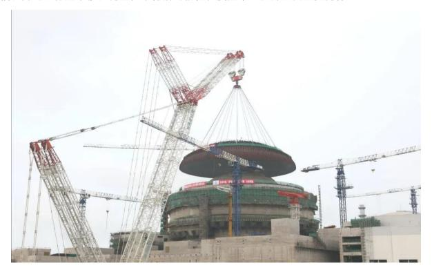
"华龙一号"示范工程建设团队基于全球首堆建设良好实践进行设计优化,创新性采用可整体吊装的钢模板作为外壳穹顶混凝土浇筑施工用模板,从根本上提高了施工的安全性和便利性。钢制穹顶模板替代传统脚手架支撑体系的做法从根本上避免了脚手架施工和使用中的安全风险,为后续穹顶混凝土结构施工工期优化提供了必要的技术支持。
