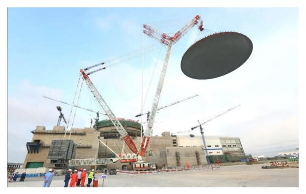
7月25日, "华龙一号"全球示范工程——中核集团福清核电6号机组顺利实现外层安全壳穹顶钢模板吊装,标志着华龙一号在建造领域得到进一步优化与提升,为华龙一号机组后续批量建设积累了宝贵施工经验。
