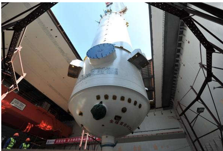
反应堆压力容器成功吊装就位,图片来源于中国核建官网,下同
