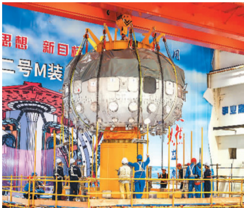
中国环流器二号M装置真空室吊装。范晋摄
