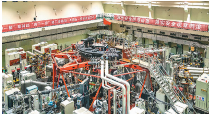
技术人员合力安装真空室外壁磁通环。范晋摄
