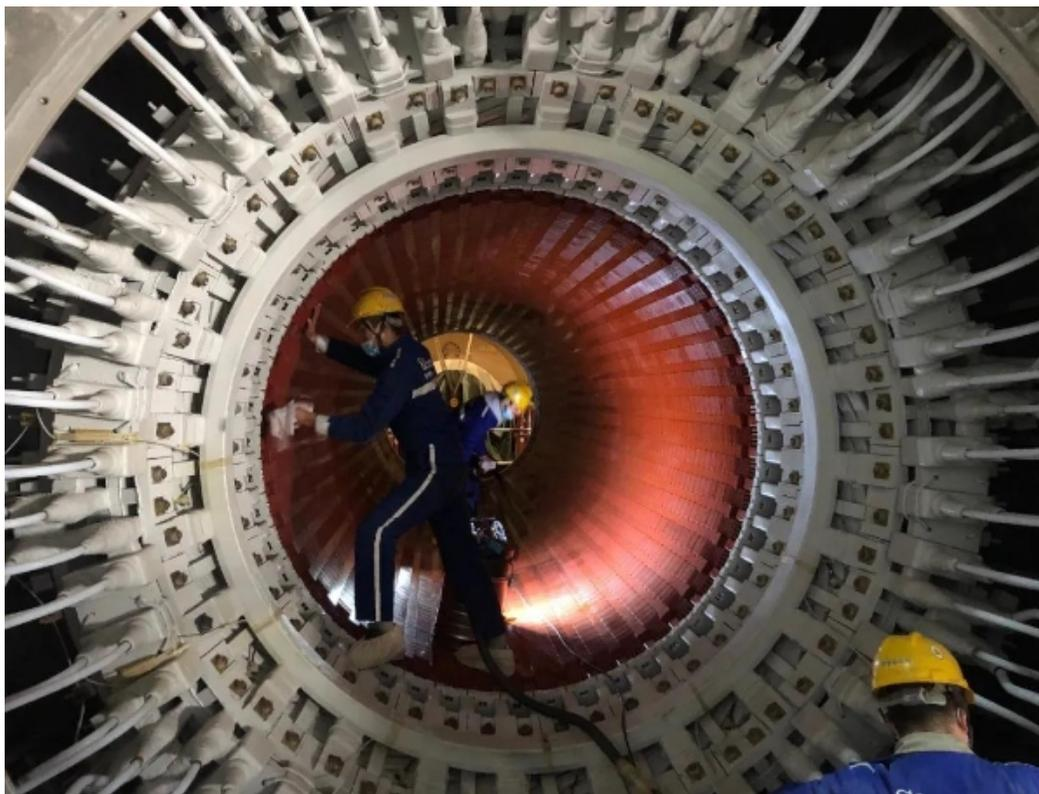
为确保发电机穿转子工作万无一失，福清核电与各协作单位积极推动各项问题有效解决，定期开展网格化监督和日常质量监督检查，在穿转子前进行防异物检查，监督穿转子全过程，确保发电机穿转子一次成功且安全质量全面受控。
