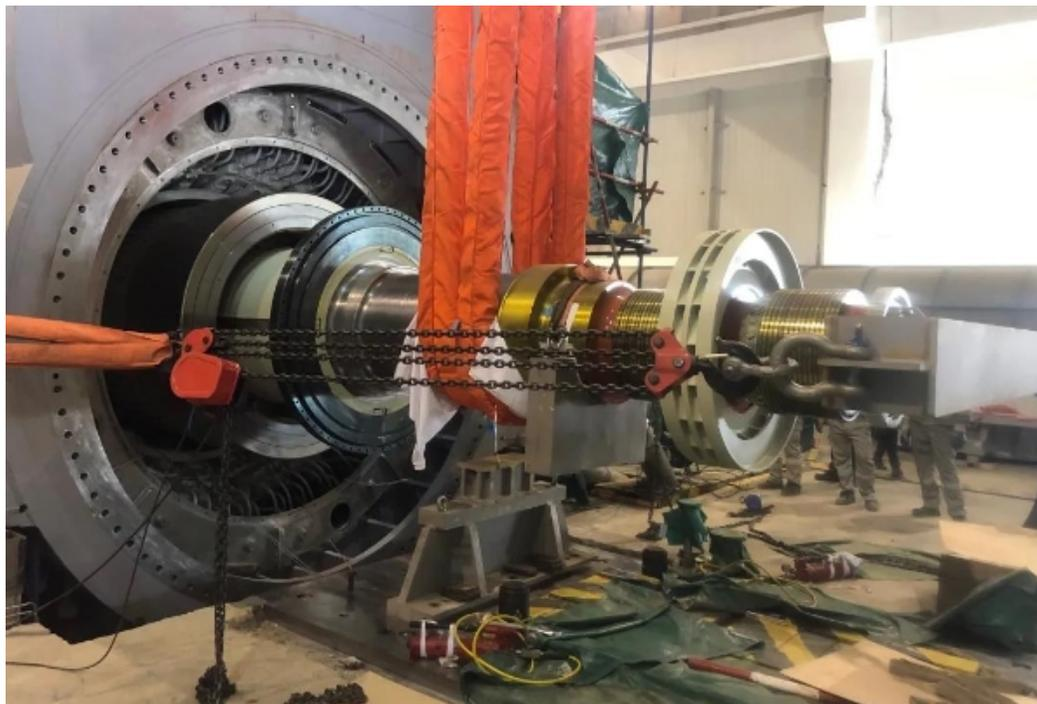
1月17日15时58分，华龙一号示范工程福清核电6号机组发电机穿转子一次成功，为后续汽轮发电机组盘车节点的实现创造了条件。
