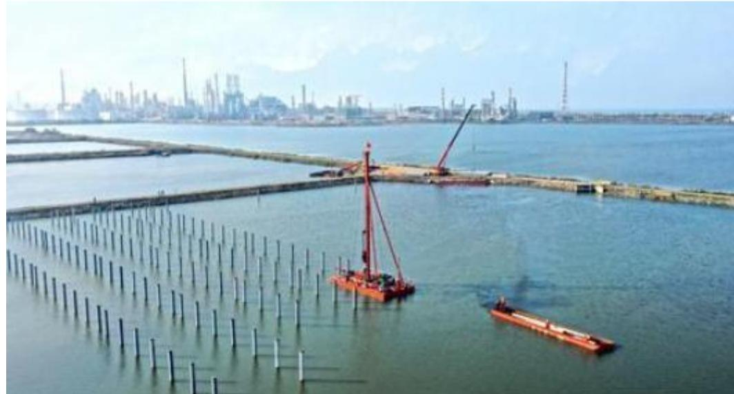
近日，青岛炼化应急水池光伏发电项目开工建设，这是该公司首个水上光伏发电项目。水上光伏发电具有天然的环境优势，由于水面没有遮挡物、日照时间较长，可显著提升发电量。该项目装机容量5.48兆瓦，采用“分块发电、就近并网”技术方案，年可发清洁绿电680万千瓦时，用于企业生产生活用电，年可减排二氧化碳6500多吨。图为10月25日该项目进行桩基施工。
