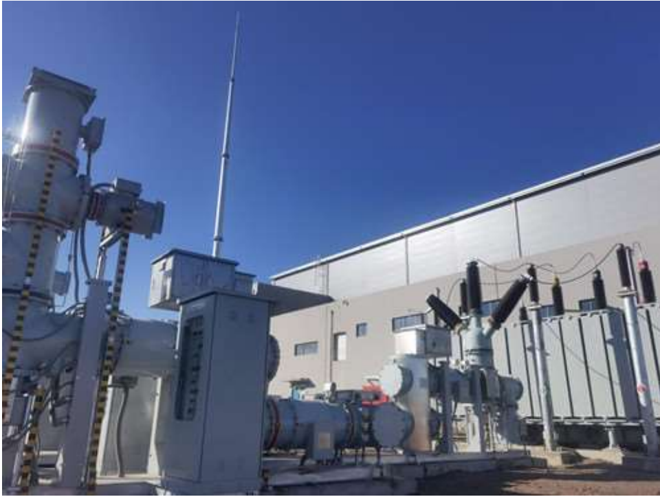
图1 百兆瓦压缩空气储能系统升压站
