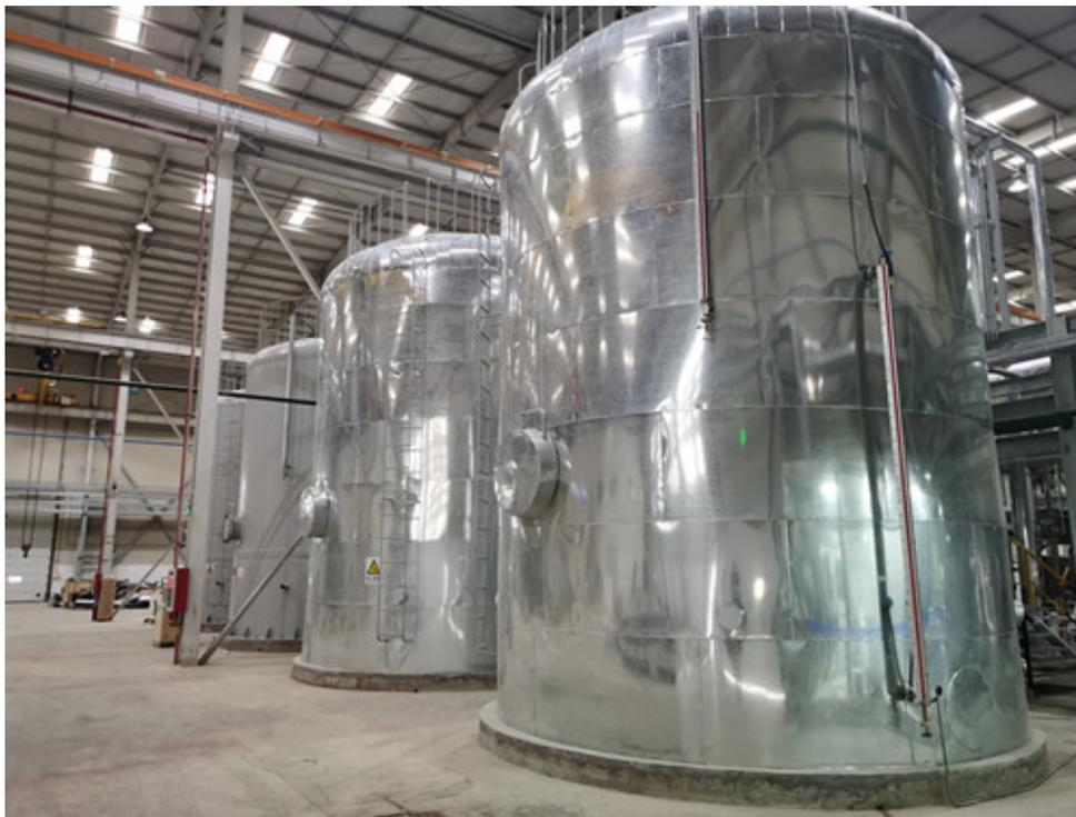
图 10MW级压缩空气储能系统蓄热装置
