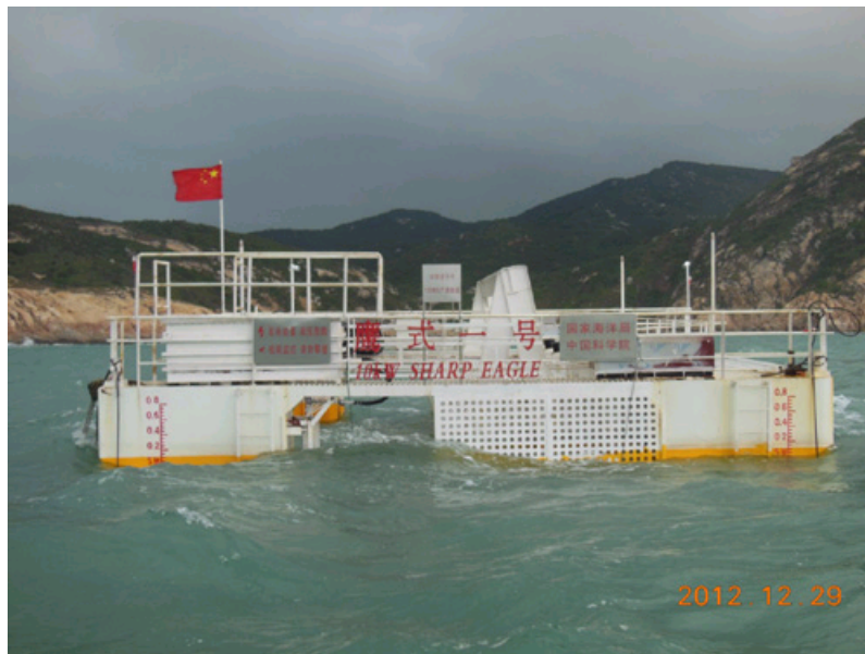
实型鹰式波浪能发电装置
