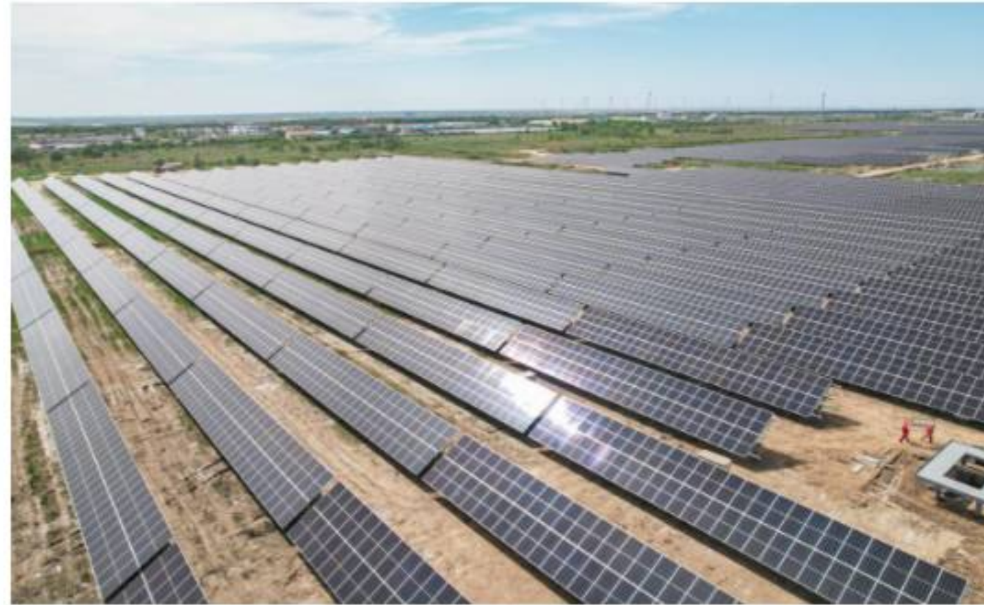
图为胜利油田孤东管理一区106兆瓦光伏电站建设工程建设现场。
