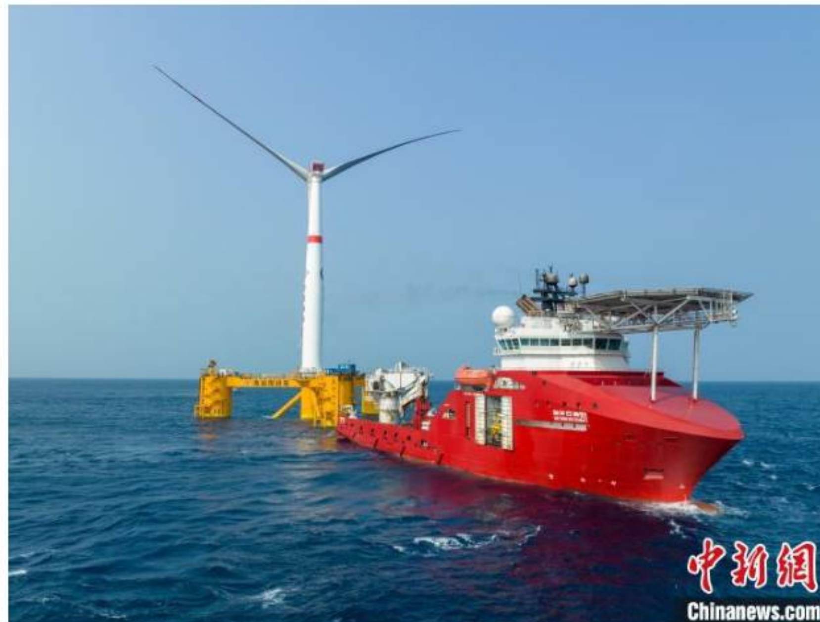
“海油观澜号”海上安装现场。中国海油 供图
