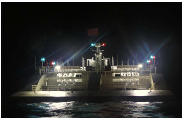
鹰式波浪能发电装置“万山号”夜间发电进行中
