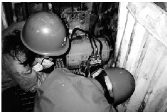
图7 分析热风挡板执行机构不动原因
