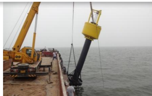
图5 波浪能供电浮标系统
