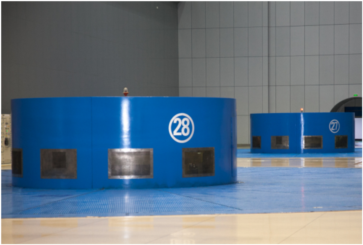
三峡电站700MW蒸发冷却水轮发电机（27号和28号机组）
