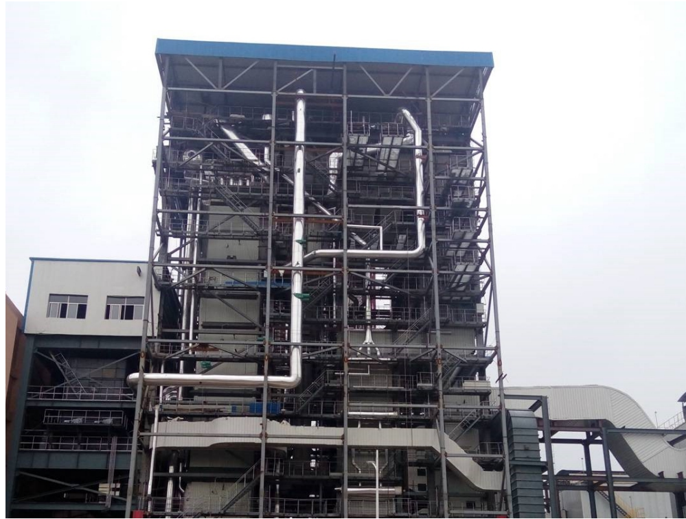
山东琦泉130吨每小时超高压带再热生物质直燃循环流化床锅炉
