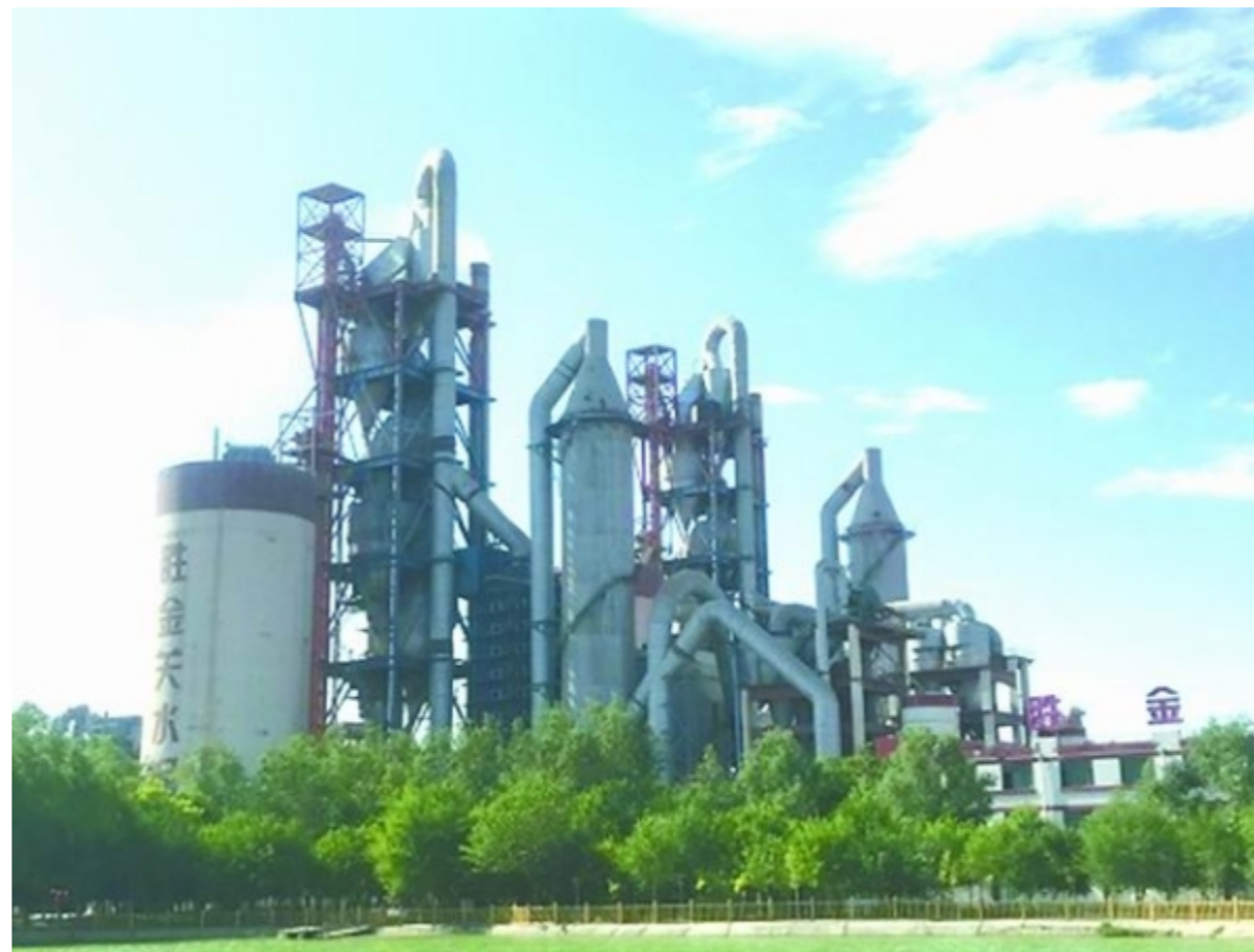
宁夏胜金2500吨/天低NO x 排放水泥窑炉示范工程 中科院工程热物理所供图
