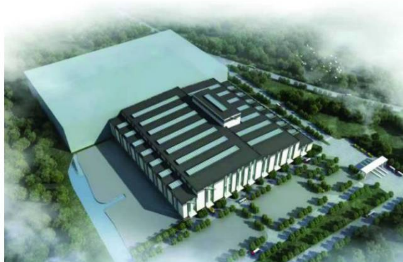
产品结构调整超薄带项目精炼综合管线和中间管线土建、安装工程
