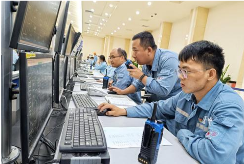
4月1日, 海南炼化8万吨/年苯乙烯装置产品分析合格, 标志着该装置顺利完成检修任务, 实现开车成功。图为苯乙烯装置内操作人员精心操作, 为脱氢反应器投用乙苯进料创造条件。曹海锋摄王梦璐文
