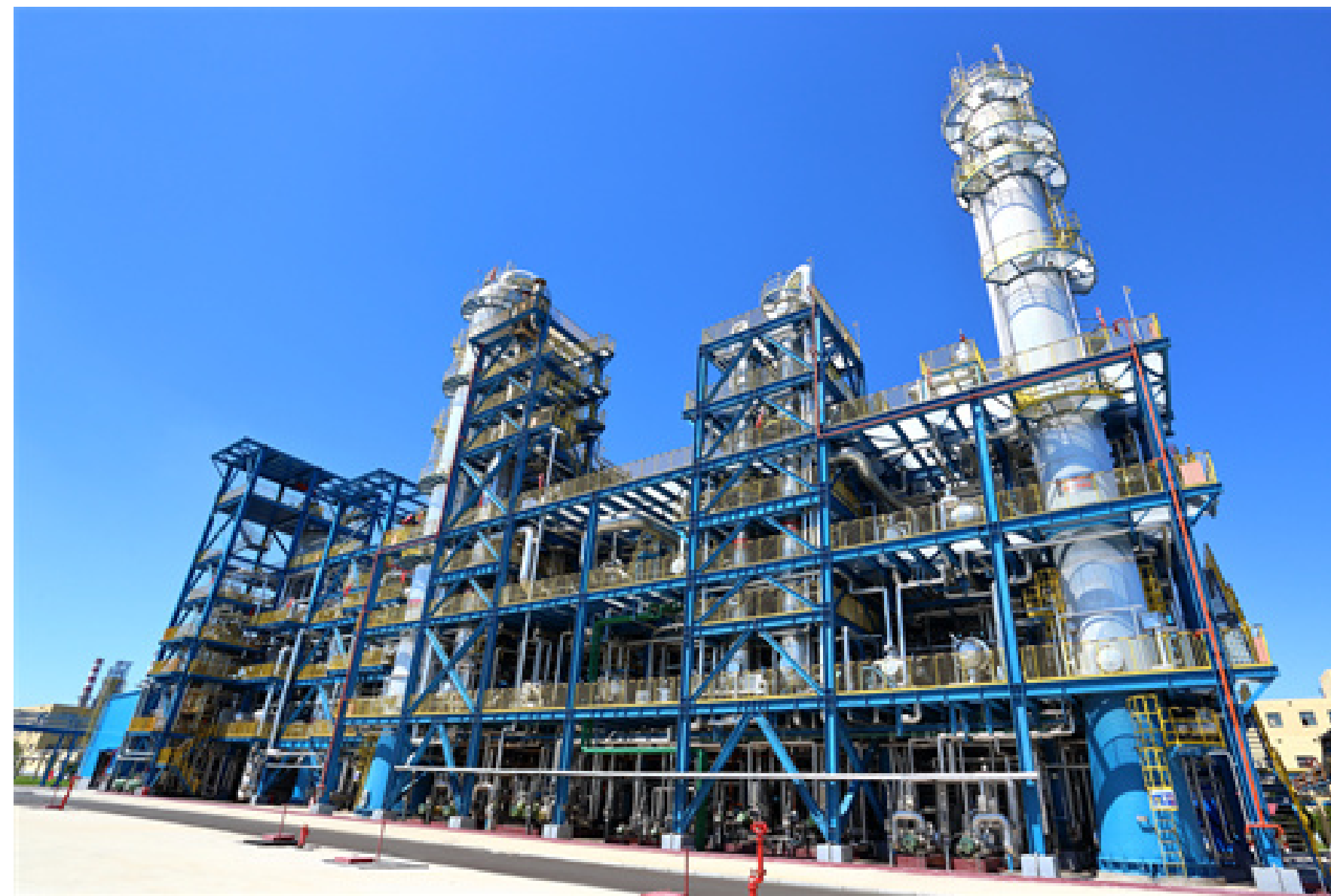
辽阳石化年2万吨CHDM项目建设现场。高晓磊 摄
