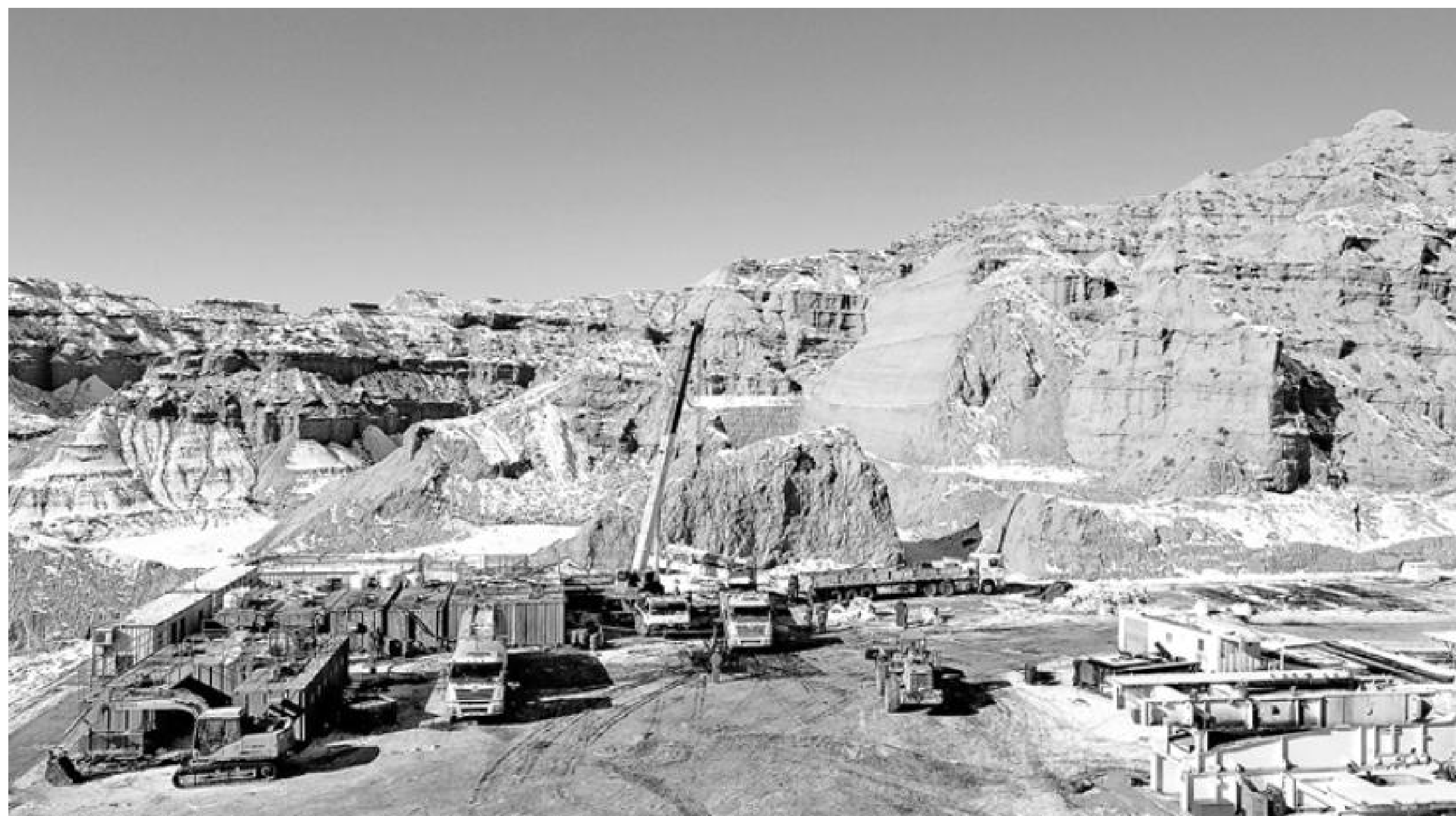
图为车辆进行搬迁吊装作业。
