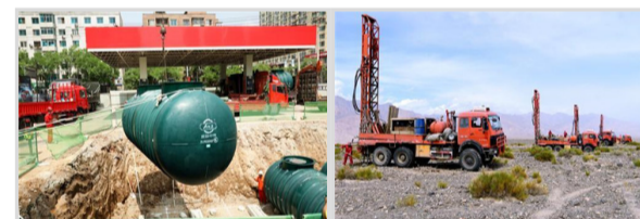
防渗改造现场 | 铁马战戈壁
