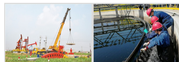
安全施工 提速提效 | 呵护环境 厂在画中
