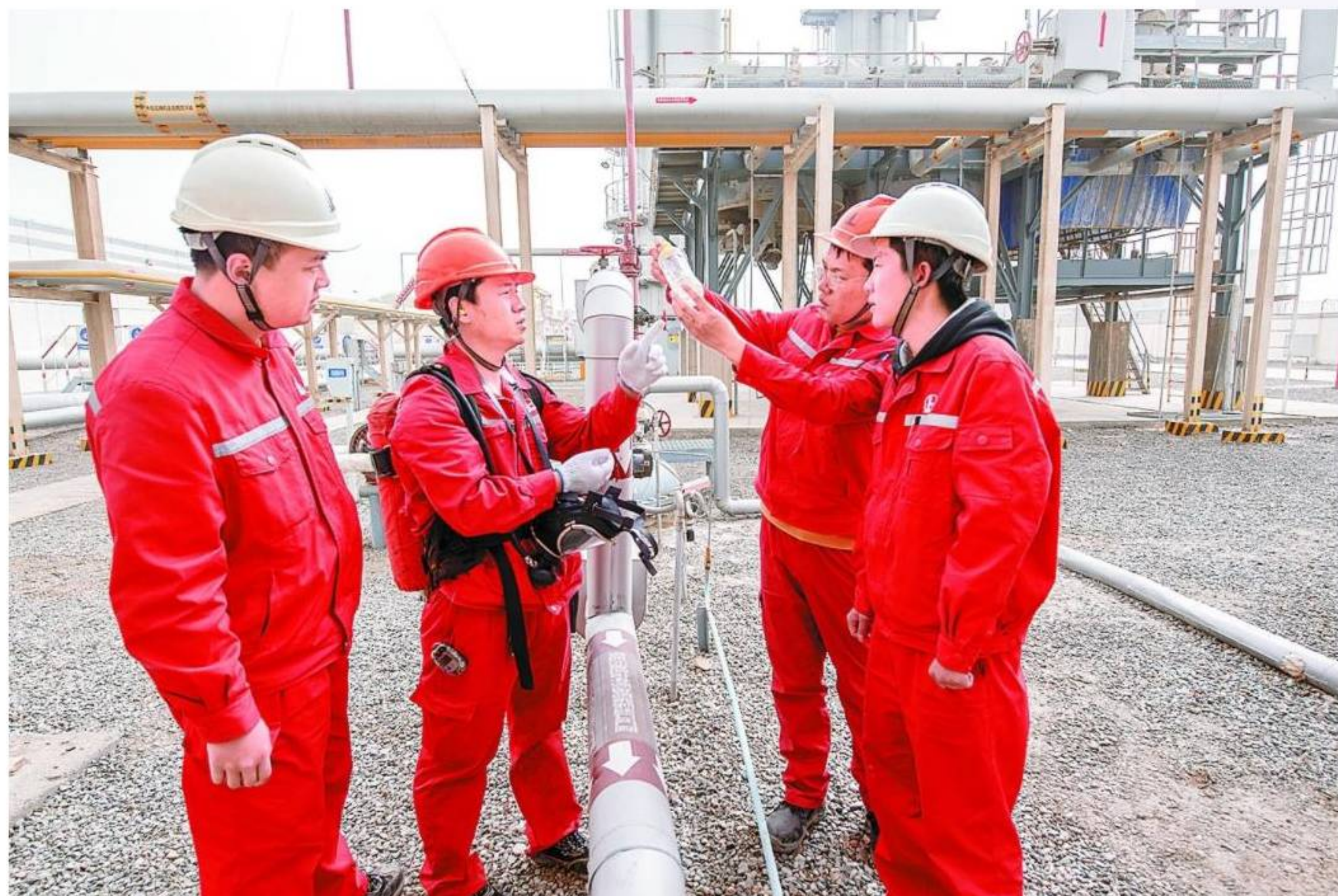
图3: 西北油田加强设备运行管理，强化油气产品质量监督，扎实做好QC小组群众性质量活动，切实将质量工作方针落实到油气生产全过程。图为4月3日西北油田三号联合站员工对混烃罐鹿脱硫酸进行取样观察。
