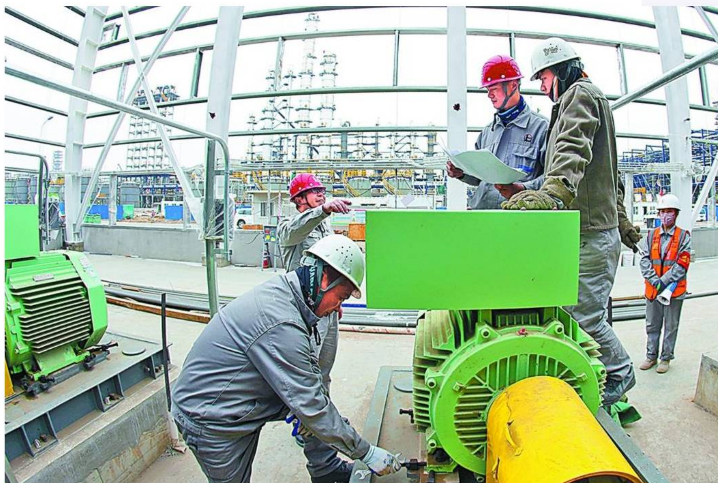
图1: 天津南港乙烯项目建设团队实施项目部、分部、监理、EPC、施工、检测、监督等七方联动的质量管理模式，常态化开展同联检、专题检等检查，坚决守住工程质量红线。图为4月3日技术人员对热力站机泵安装质量进行检查。
