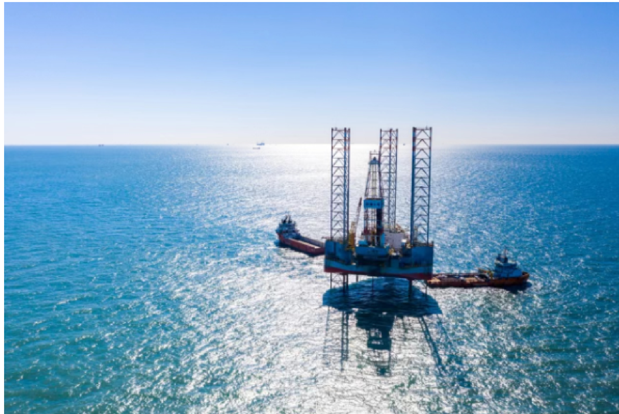
海上钻井平台正在渤中26-6油田进行钻探作业。受访者供图
