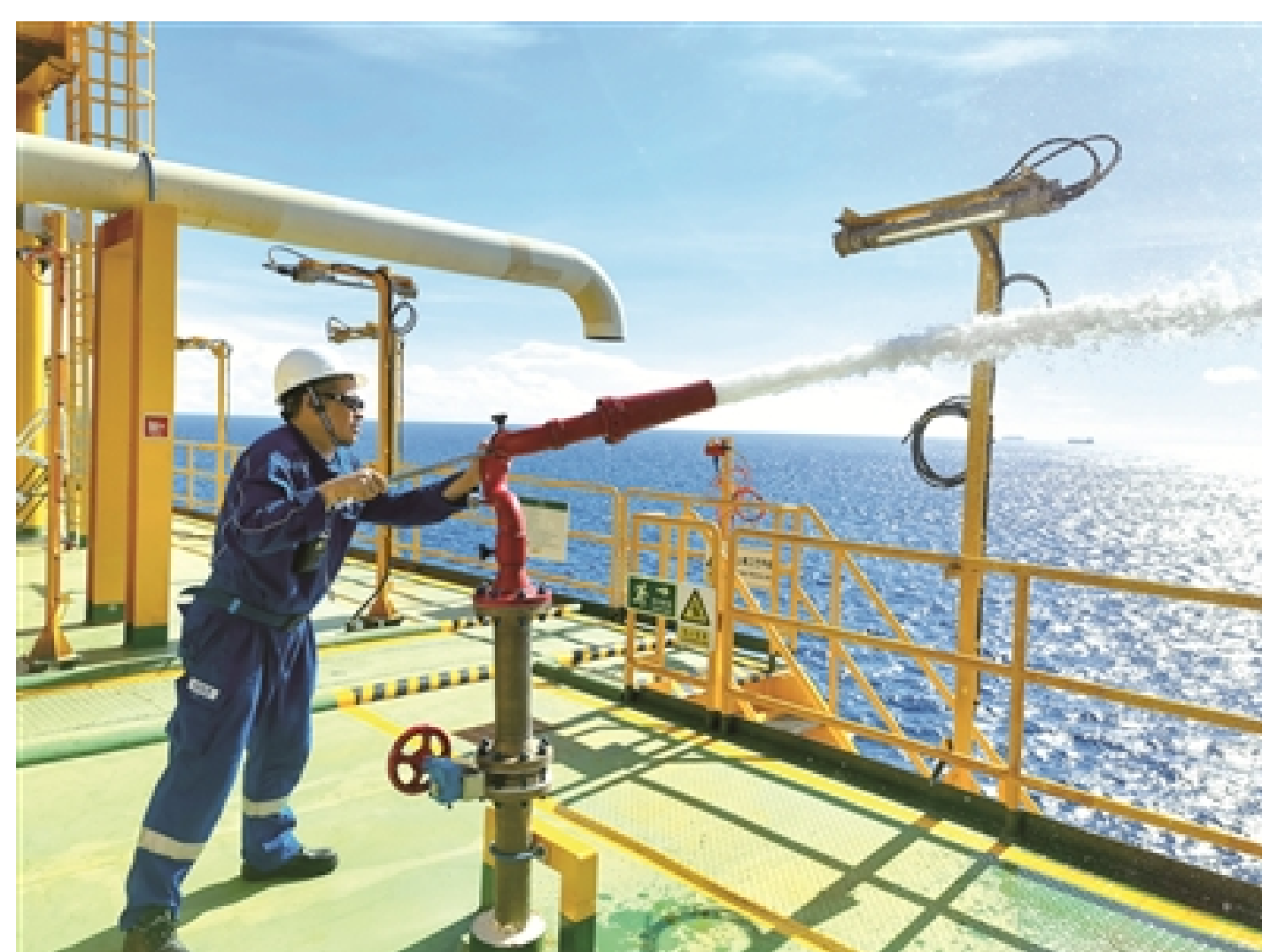
图②：工作人员正在调试“海洋石油123” FPSO上的消防炮系统。
