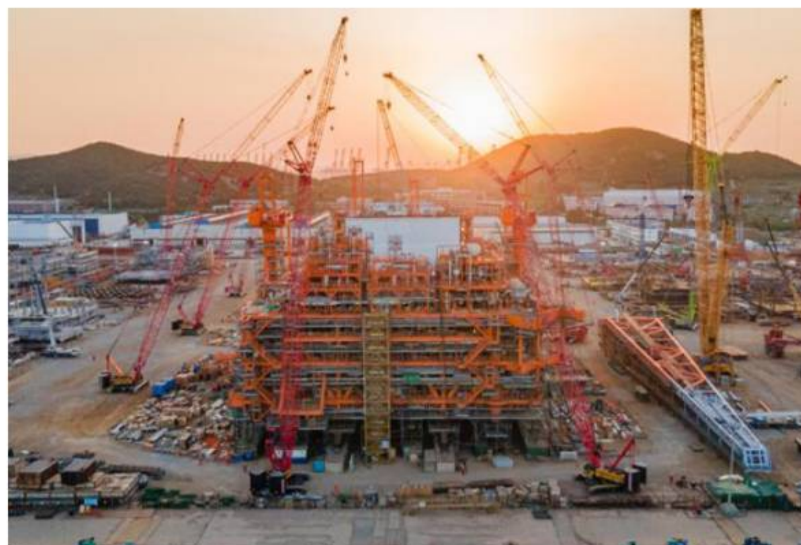
渤中19-6项目中心平台在青岛建造完成。
