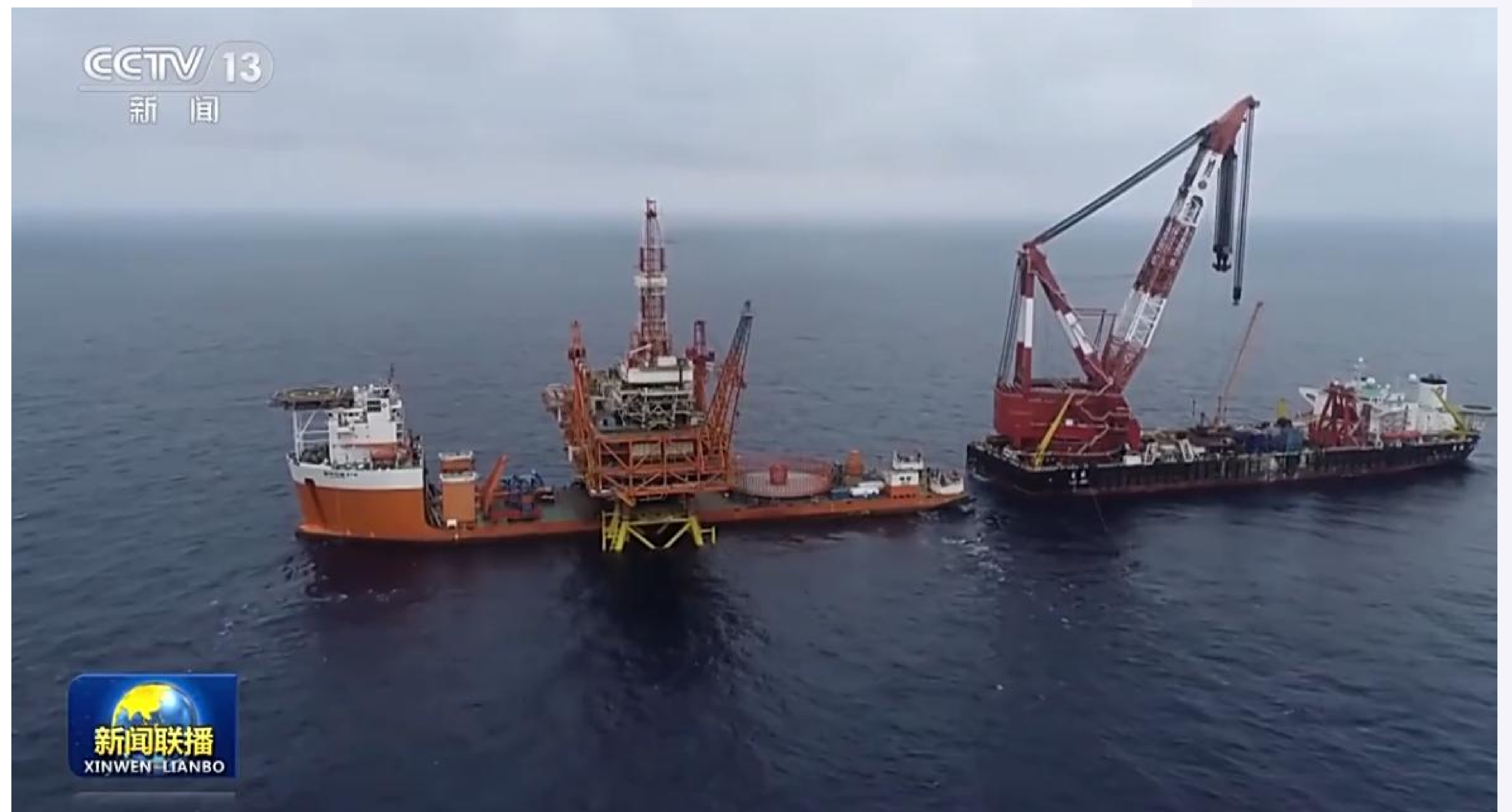
经过近6个小时的作业,下午六点,恩平20-4海上钻采平台与之前已经安装在海底,高达百米的导管架,成功实现了精准对接。
