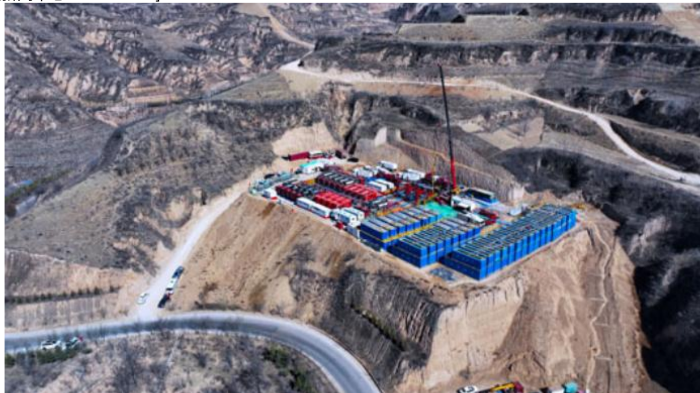
图为长城钻探在煤层气市场的首个电驱压裂平台——吉深5-8平台。
