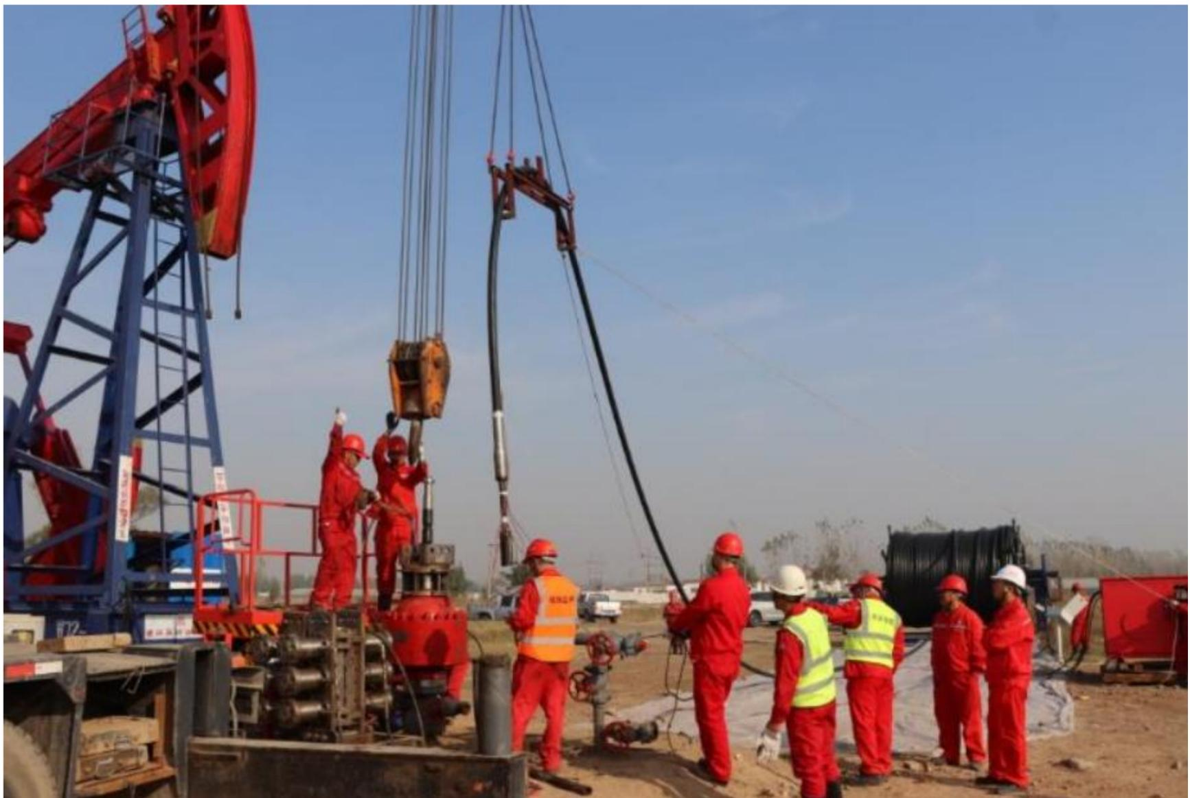
图为现场施工人员正在准备进行潜油电泵电缆连接。
