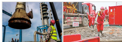
检修进行时 泥泞井场“石油红”
