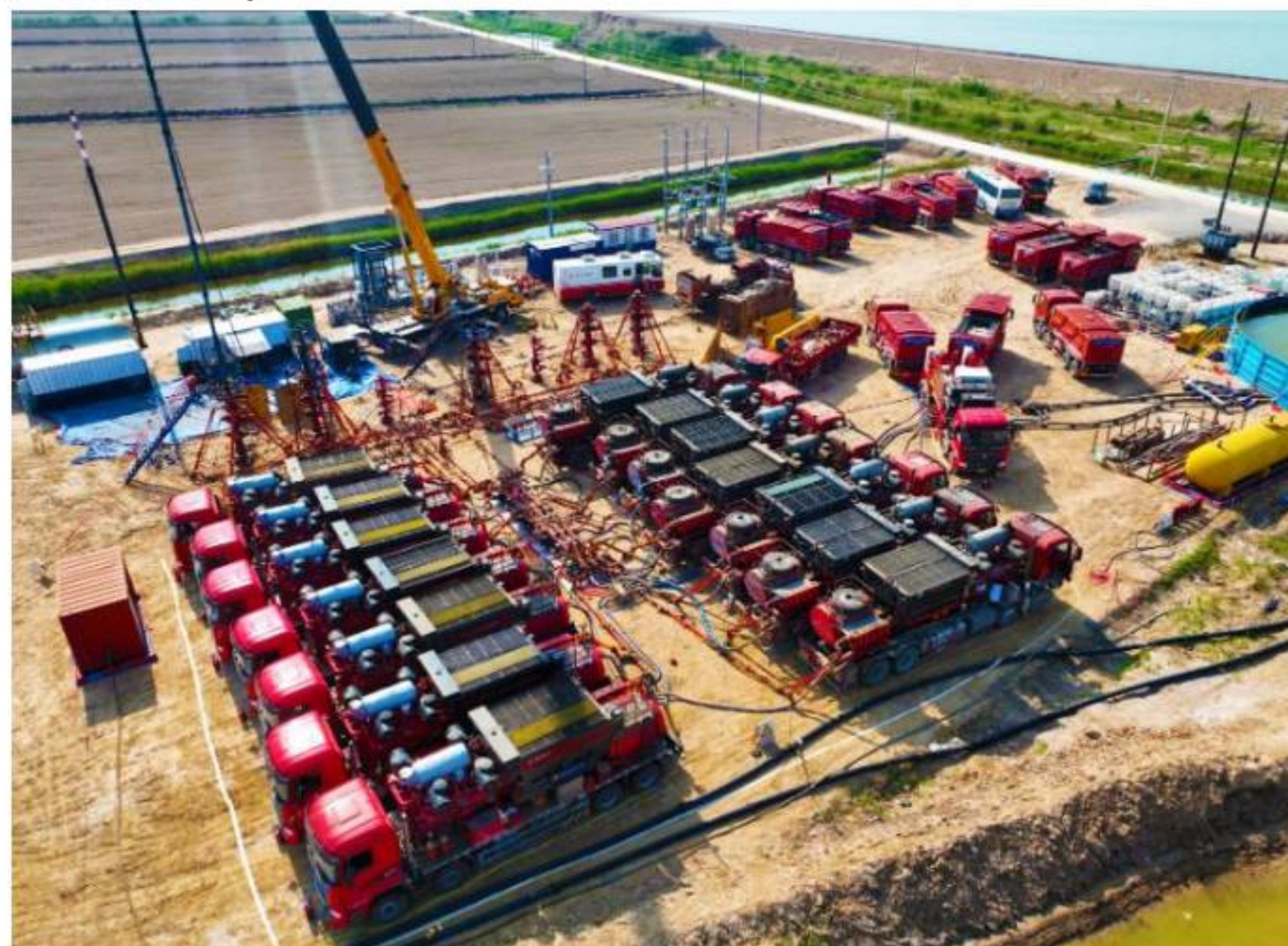
5月8日,胜利油田河口采油厂对渤南油田南区新井顺利完成反向压驱补能压裂施工。该工艺技术为新井创新设计“反向压驱补能+精细分段压裂”的工艺方案实施,推进渤南沙四红层,新老区储量向效益产量转化增能提效新模式。1—5月,河口采油厂已对51口油井实施反向压驱补能。
