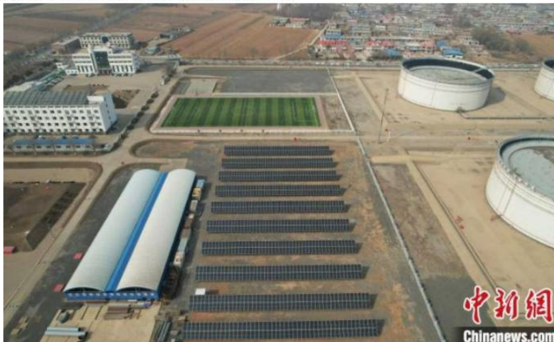
渤海油田首个兆瓦级光伏发电项目并网成功。
