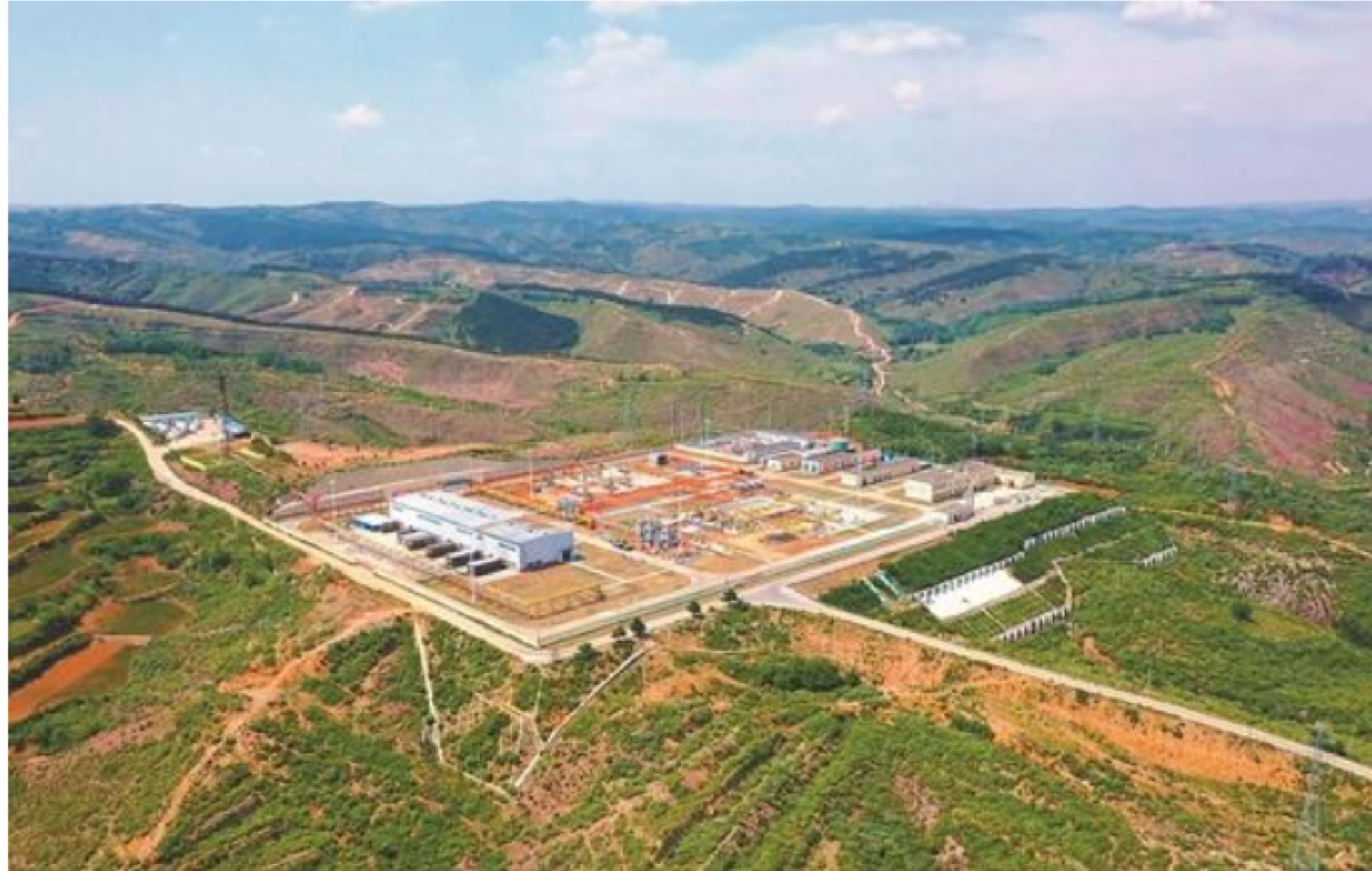
图为位于山西沁水盆地的华北油田山西煤层气分公司煤层气处理中心鸟瞰图。姜浩然 摄
