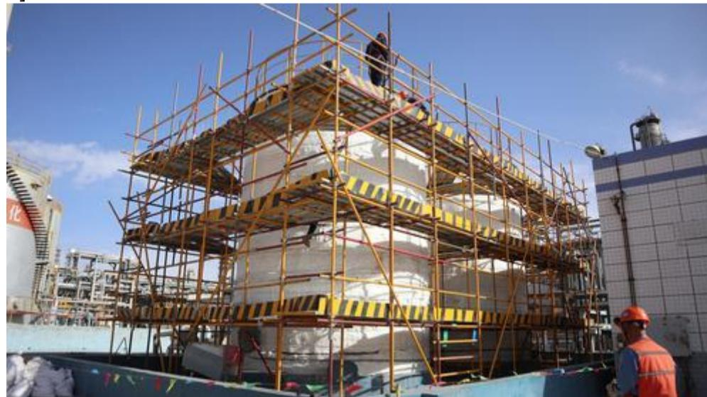
近日，塔河炼化开展冬季防冻防凝措施的准备工作。该公司公用工程作业部组织各专业强化落实防冻防凝方案，深挖防冻防凝隐患，更换重要储罐和管线保温层，为冬季安全生产保驾护航。图为员工为储罐更换保温层。王小霞摄
