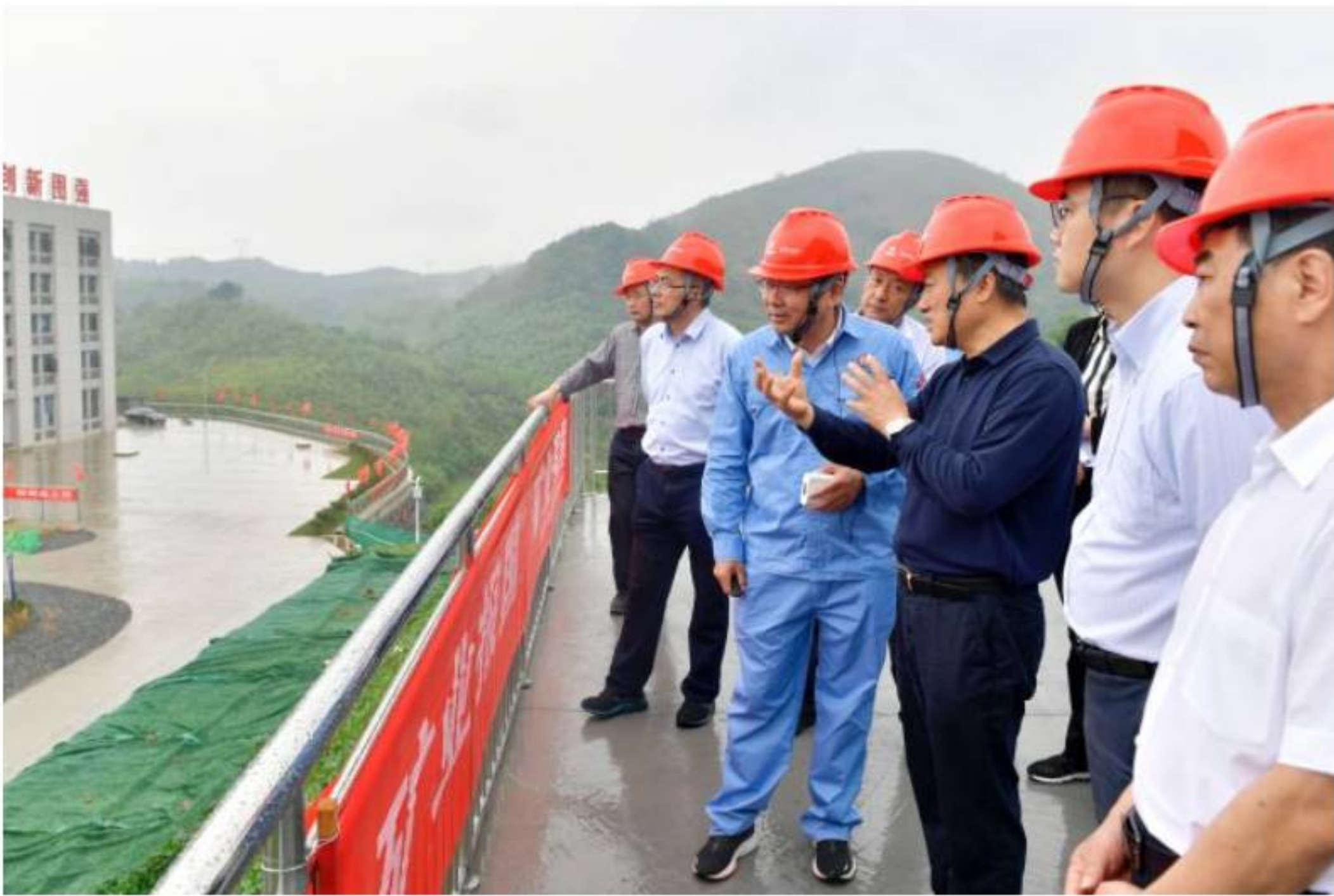
翁祖亮在水口山康家湾技术升级改造项目现场调研1
