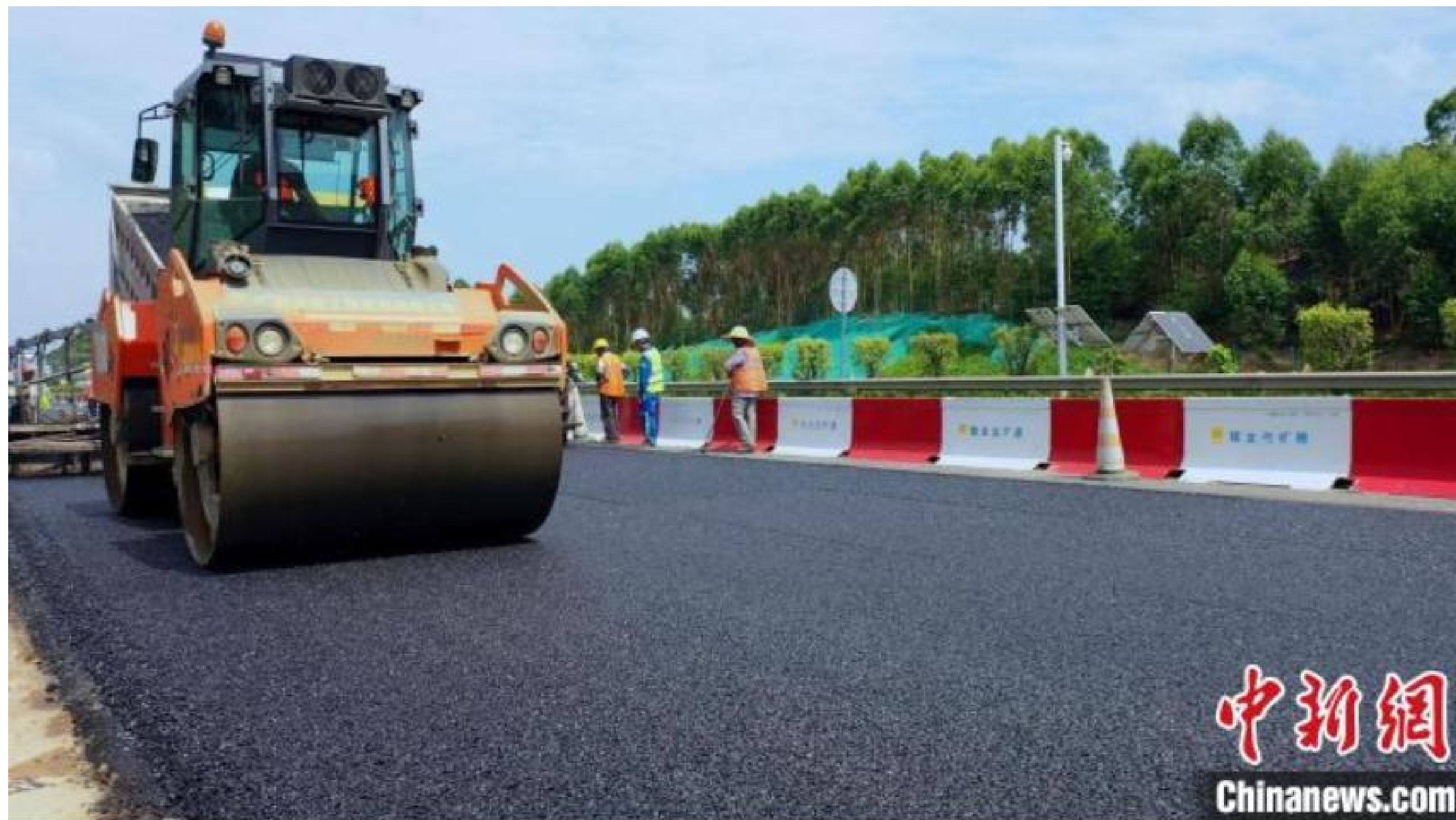
图为高性能橡胶沥青技术在钦北改扩建项目应用示范。
