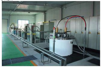
4月19日,由中国科学院电工研究所承担研制的中国首座超导变电站在甘肃白银市正式投入电网运行。这也是世界首座超导变电站,标志着我国在国际上率先实现完整超导变电站系统的运行。这座变电站的运行电压等级为10.5 千伏,集成了超导储能系统、超导限流器、超导变压器和三相交流高温超导电缆等多种新型超导电力装置,可大幅改善电网安全性和供电质量,有效降低系统损耗,减少占地面积,在核心、关键技术上获得了近70项完全自主知识产权。
