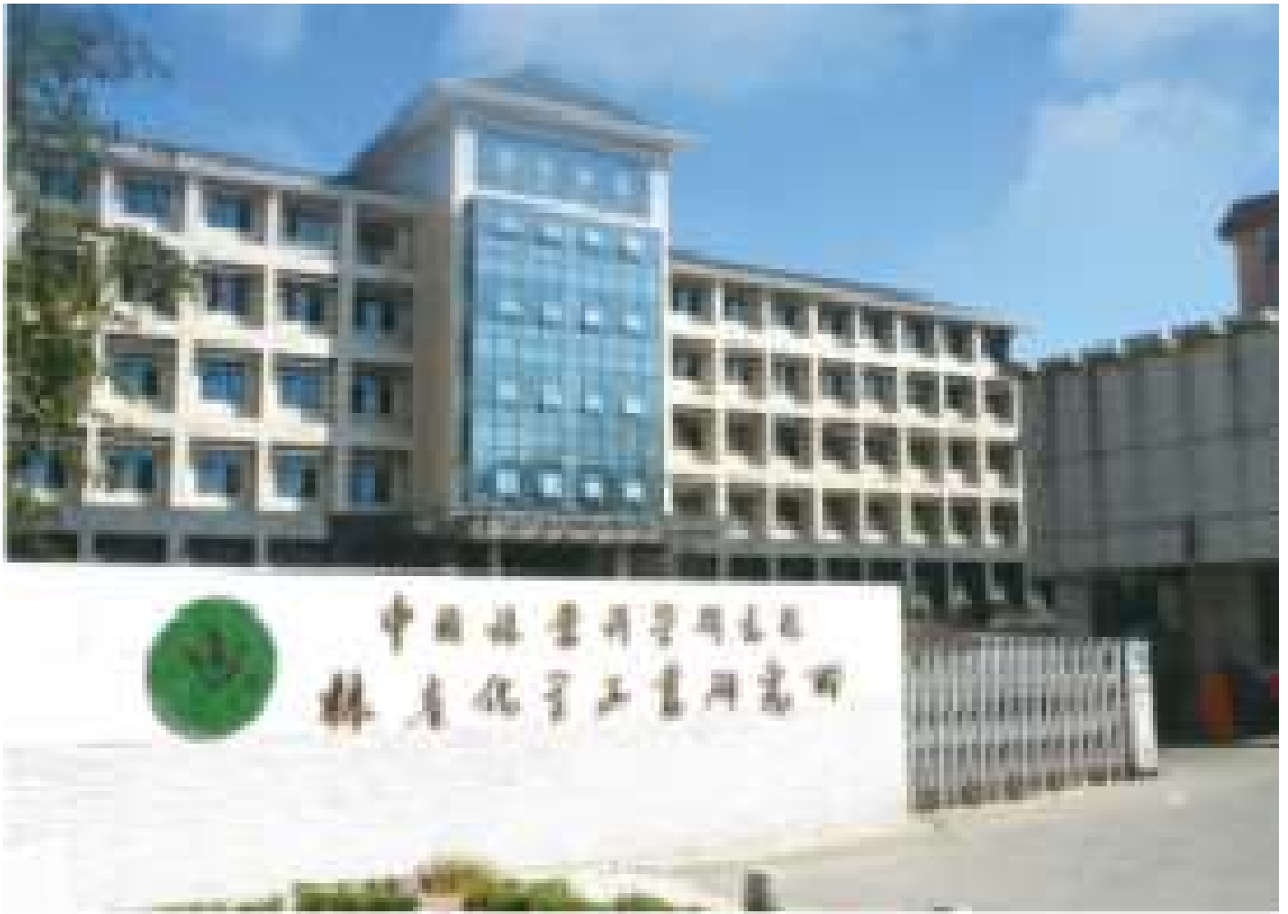
2010年改建后的科研大楼
