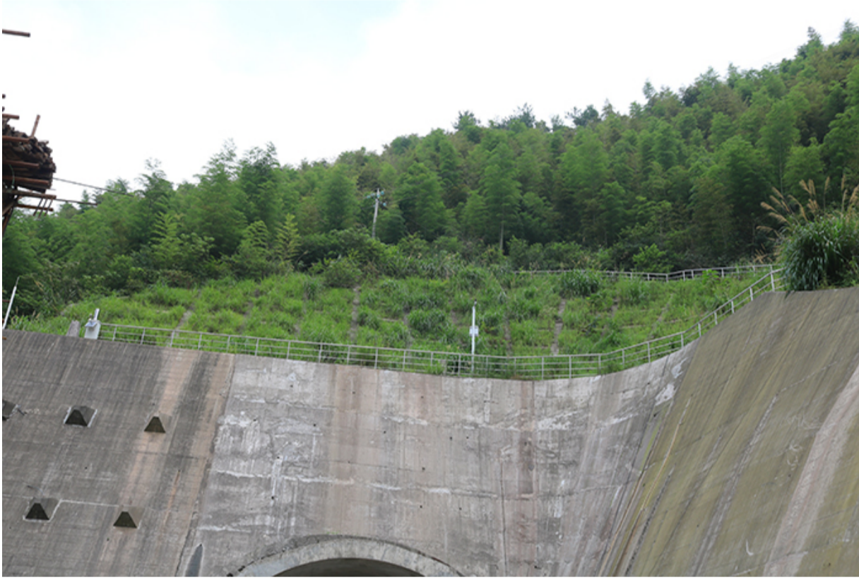
右岸低线隧道洞脸绿化
