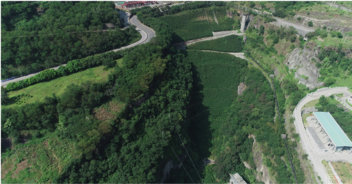
溪洛渡沟弃渣场框格梁护坡及绿化
