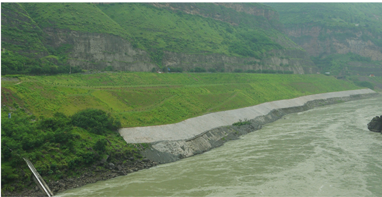
溪洛渡癞子沟弃渣场护坡及绿化
