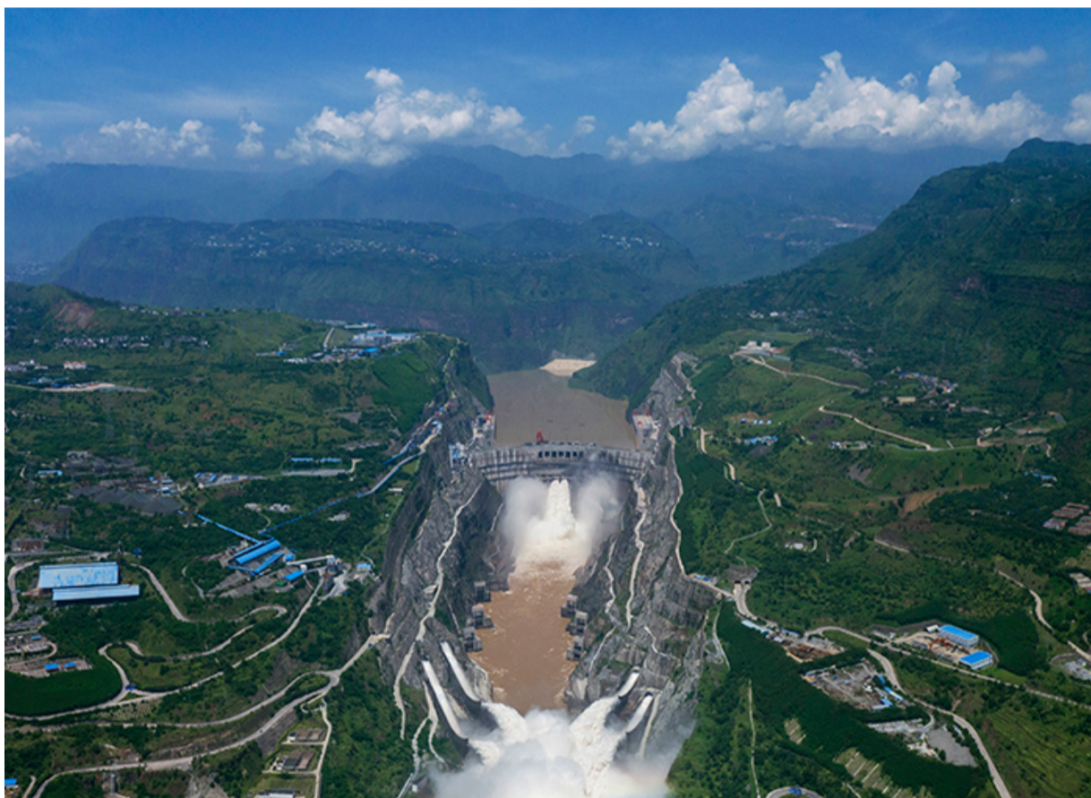
溪洛渡水电站全景
