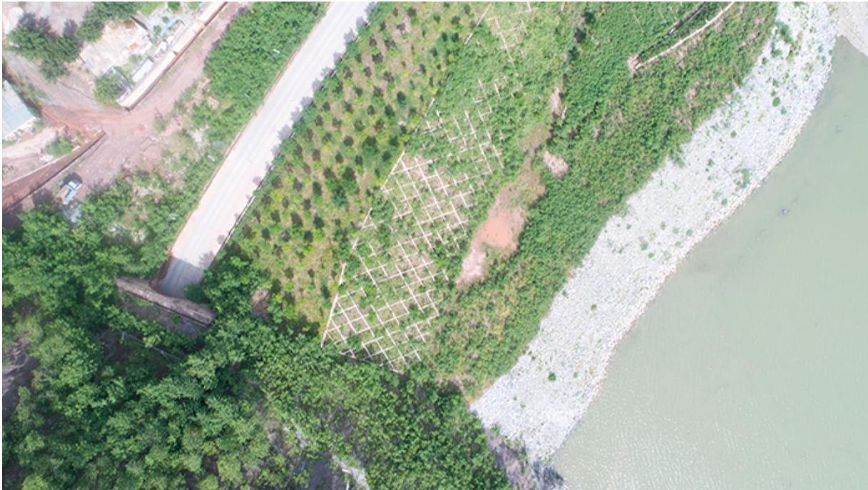
下白滩弃渣场框格梁防护及绿化
