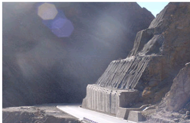
已实施超前支护的高切坡
