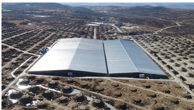
水切伦科夫探测器阵列的三个水池构筑物鸟瞰图。(图片来源:中科院高能所)
