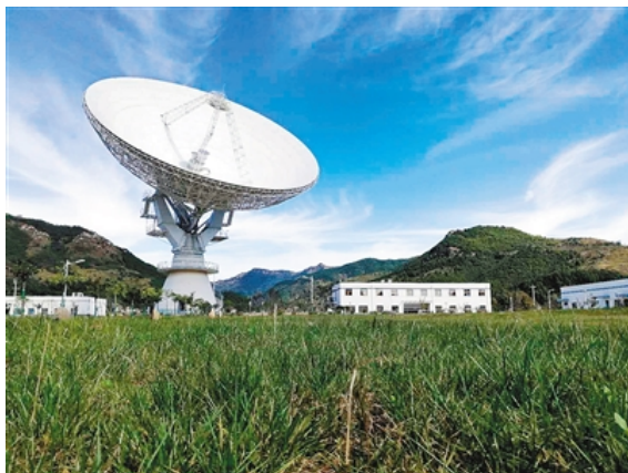
国家授时中心在秦岭山中建设的40米口径射电望远镜。(中科院国家授时中心供图)
