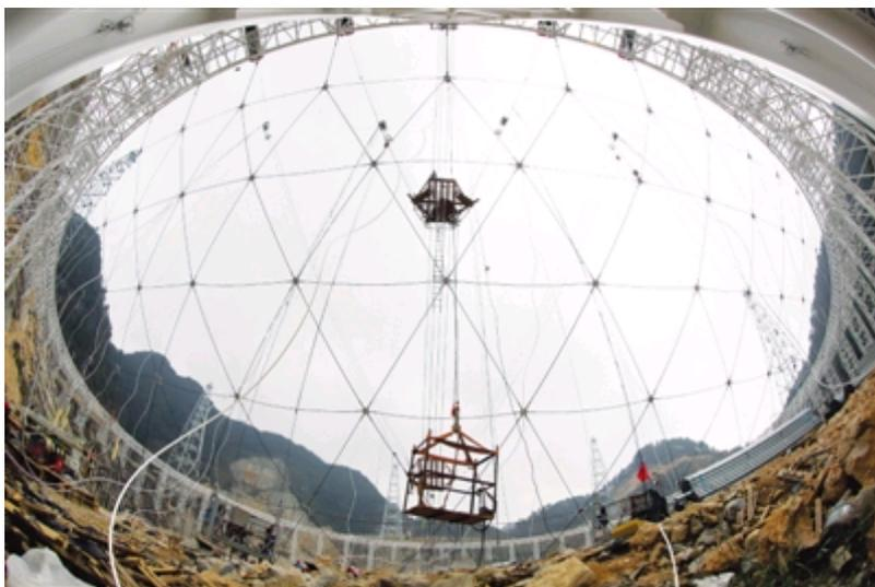
2月4日上午，位于贵州平塘的500米口径球面射电望远镜（FAST）安装了最后一根钢索，索网制造和安装工程结束。这意味着FAST的支撑框架建设完成，进入了反射面板拼装阶段。
